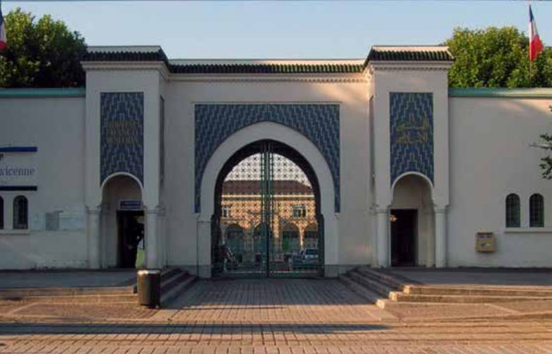
Façade de l'hôpital Avicenne, Bobigny © JB Debost/CG93
